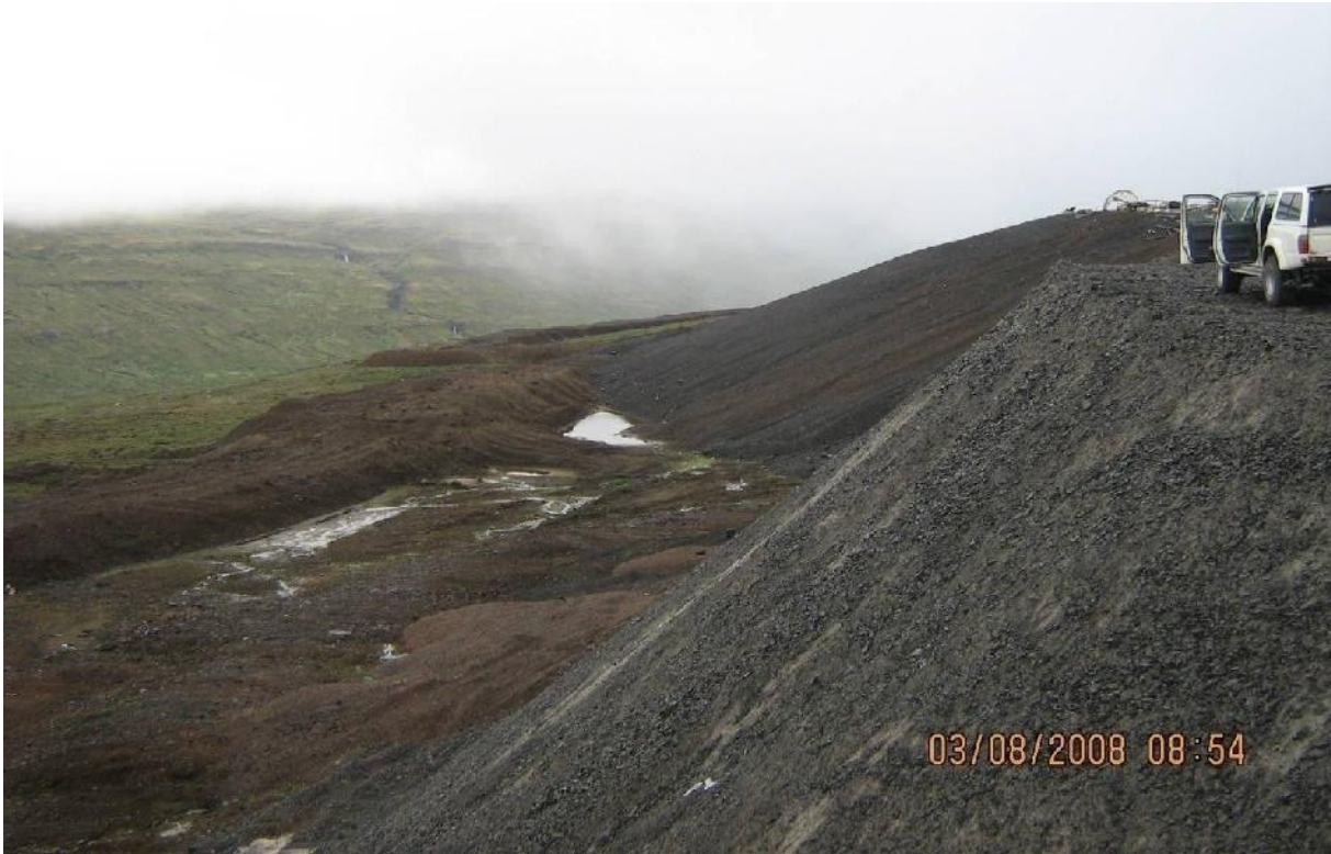
Haugsvæði áður en endanleg mótun haugsins hófst. Brúninni var víða ýtt fram til að halli haugsins væri líkari landhalla í næsta nágrenni og til að minnka líkur á vatnsrofi og auðvelda uppgræðslu haugsvæðisins. (03.08.2008)
