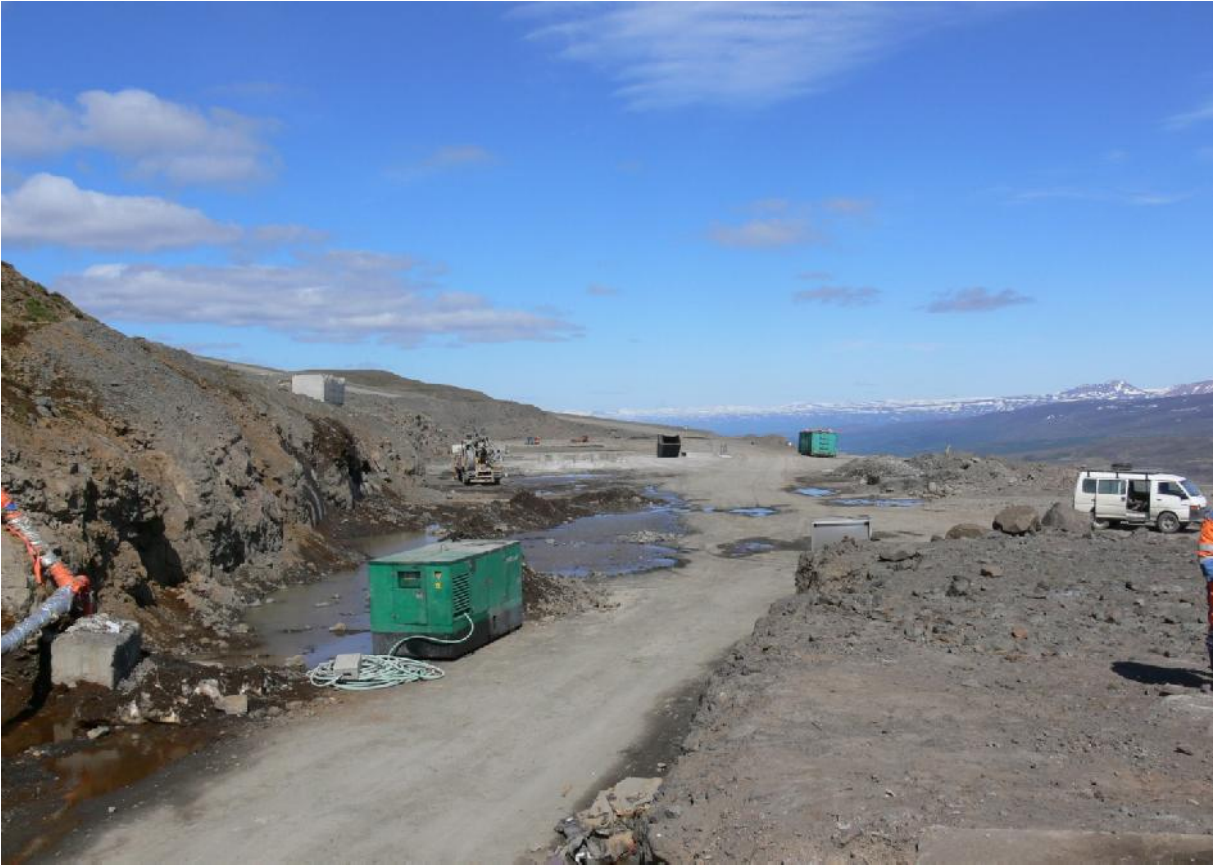
Búið að taka steypustöð niður. Vegur var fluttur ofar á planið til að brekkan yrði samfelldari ofan og neðan vegar. Horft til norðurs.
