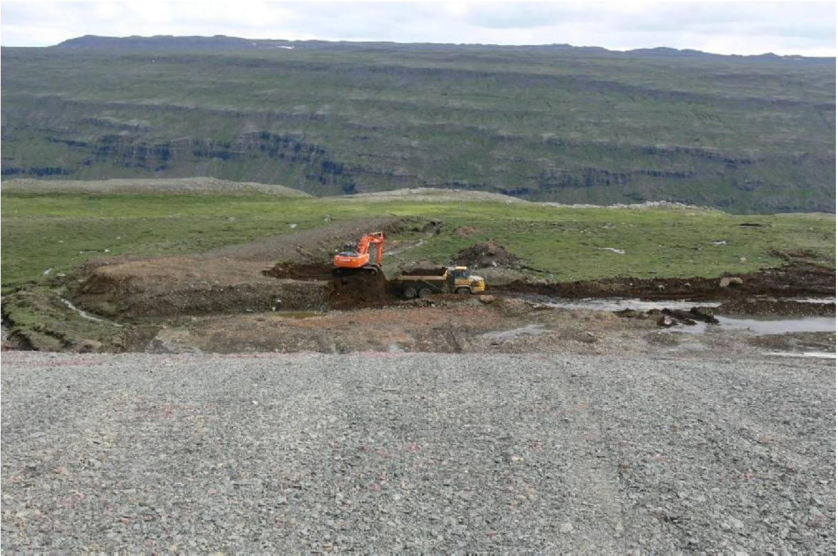
Flutningar á mold til frágangs á yfirborði. (06.07.2009)
