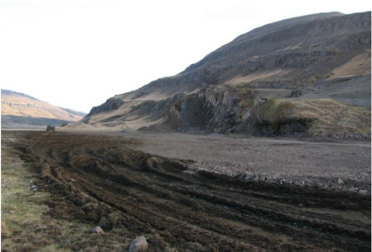
Úr þessari námu var tekið grjót í rofvörn við frárennisskurð Kárahnjúkavirkjunar. (10.05.2007)
