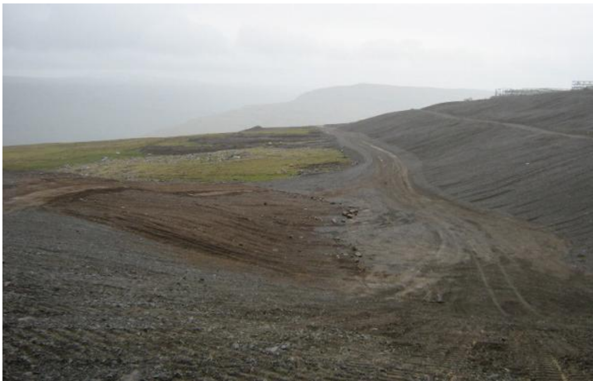
Búið er að taka niður færribönd sem sjá má efst á haugnum til hægri. Steyptar undistöður hafa verið fjarlægðar. (15.07.2008)
