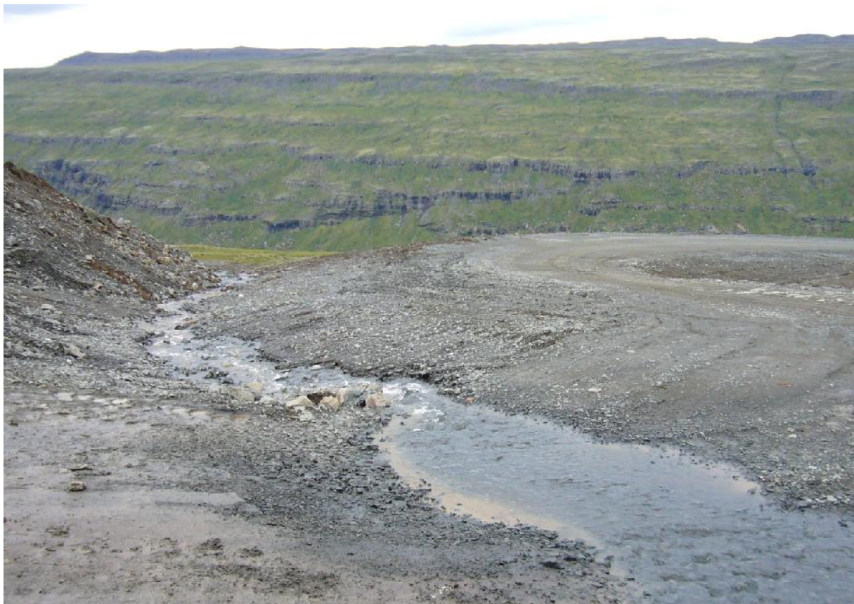
Mótun vegar og vatnsrásar lokið. (12.08.2009)
