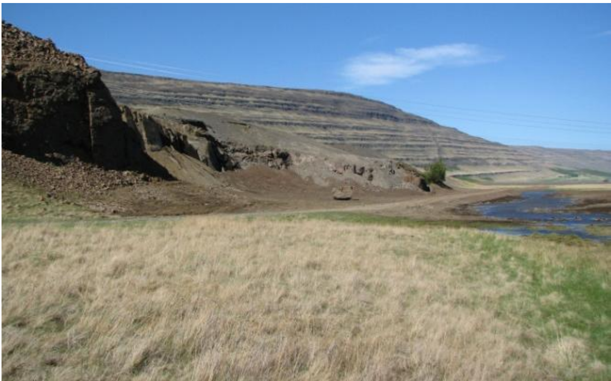
Við frágang námunnar nýttist efni úr námuplani til að gera fláa við bergstál í líkingu við brekkur sem sjá má neðan kletta innan við námuna. Lífrænn jarðvegur sem féll til við gröft frárennisskurðar nýttist við frágang námunnar. Vegur var endurbyggður um námuplan. (06.06.2007)
