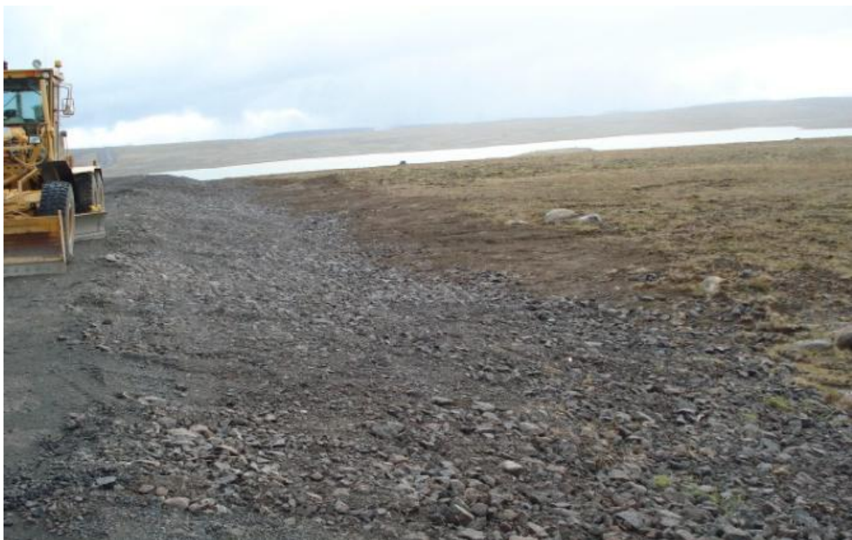
Mótun fláa og lands utan fláafótar lokið. (08.09.2009)
