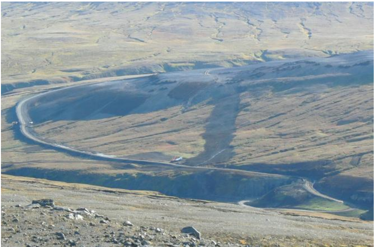
Færíbandaslóð að lokinni landmótun. (10.09.2009)
