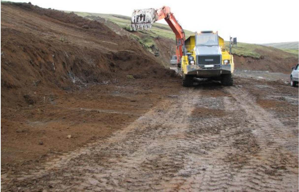
Mótun skeringar: Efni sem flutt var burt var nýtt til frágangs á ýmsum svæðum s.s. haugsvæði og svæði við gangnamunna. (27.08.2009)
