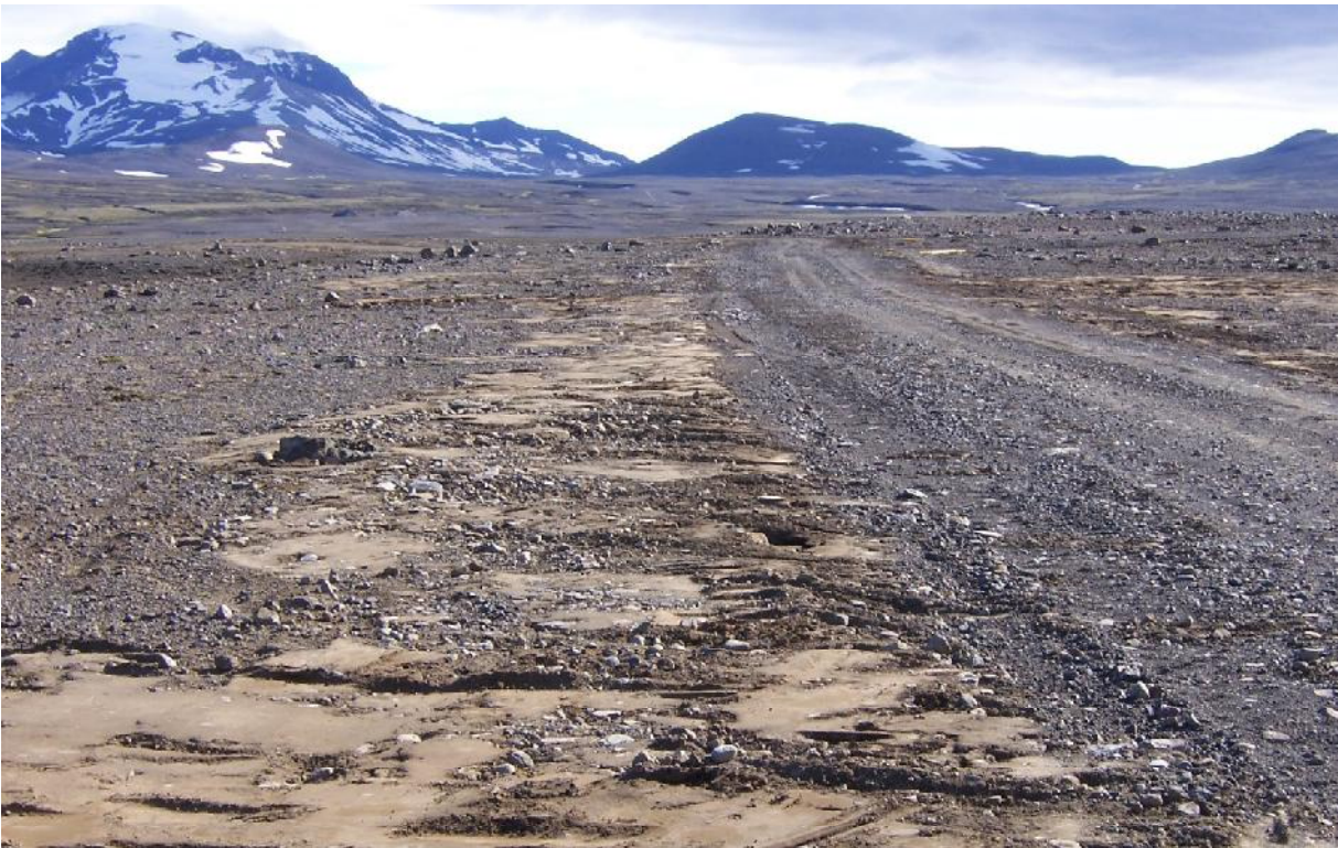
Grjóti sem rutt hafði verið úr vegstæði var grafið til hálfvís við veginn. (14.07.2008)
