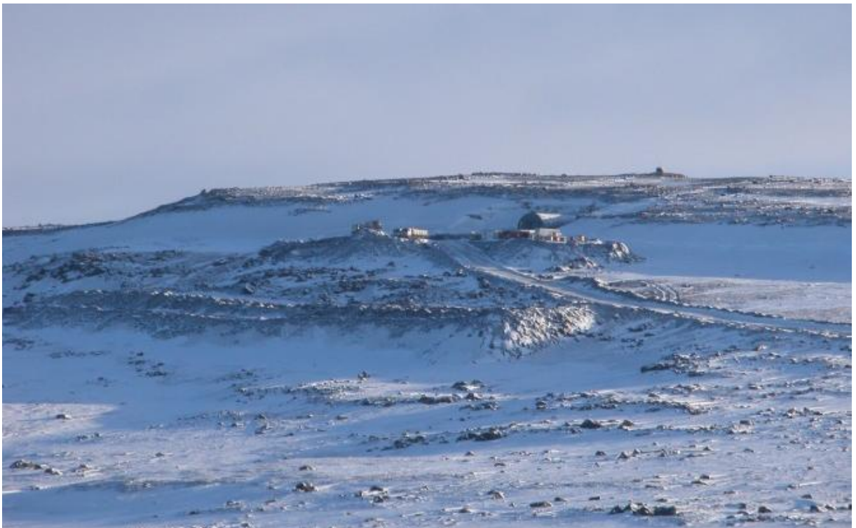
Við Miðfell voru grafin sveifflugöng sem liggja að aðrennslisgöngum. Hlutverk sveiffluganga er að taka við og leiða vatn frá aðrennslisgöngum ef til skyndilegrar stöðvunar Kárahnjúkavirkjunar kemur. Á myndinni sést plan framan við gangnamunna og haugsvæði neðan við hann. (08.02.2006)
