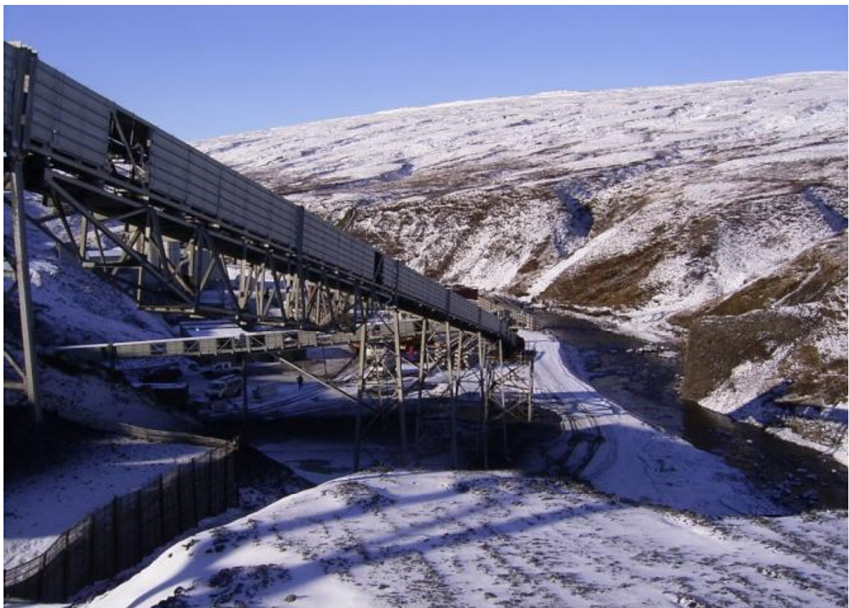
Aðstaða verktaka við aðkomugöng III. Fremst á myndinni er færiband sem flutti efni úr jarðgöngunum á haugsvæði. Í bakgrunni sést steypustöð og verkstæði. (07.10.2004)
