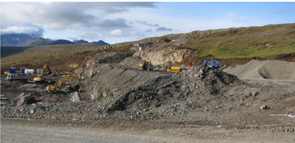
Athafnasvæði Impregilo við aðgöng II, efri hluti svæðis. Vegur færður ofar á athafnasvæði. Flytja þurfti að efni og jarðveg til að móta samfellda brekku frá vegi um efri stall að óraskaðri brekku ofan athafnasvæðis. (15.09.2008)
