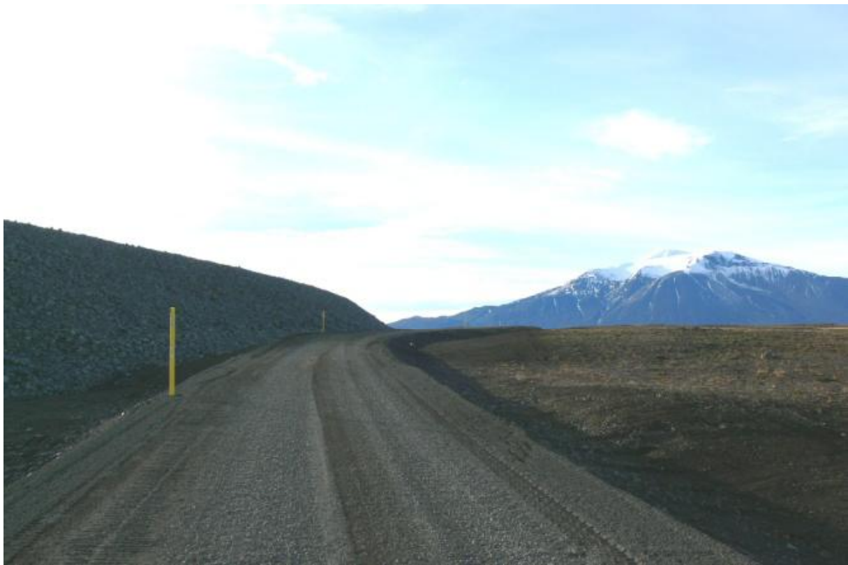
Aðkomuvegur við Kelduárstíflu. Frágengnar skeringar. (10.2010)
