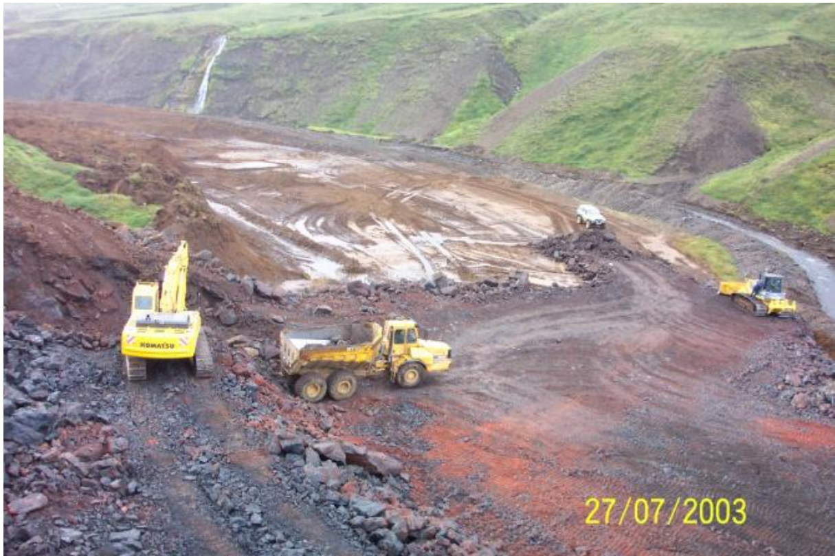
Undirbúningur framkvæmda. Efni í planið kom að hluta úr efni sem mokað var frá gangnamunnum. (27.07.2003)
