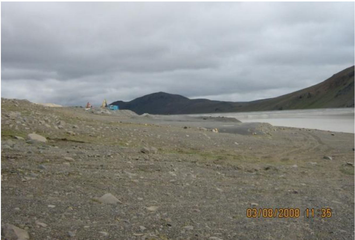
Unnið við að rífa steypustöð. (03.08.2008)
