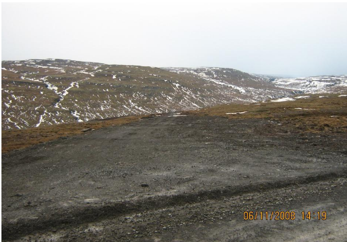
Færibandaslóð ofan gangnamunna nýttist sem vetrarvegur. Ástæða þótti að fella veginn betur að landi. Efni úr veginum var fjarlæggt án þess að skerða verulega burðargetu hans. Vegurinn verður græddur upp. (06.11.2008)
