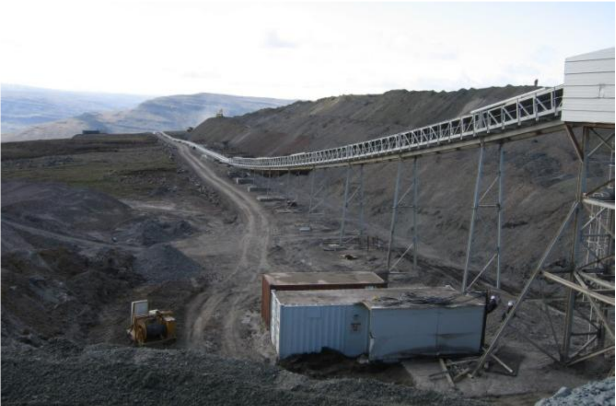
Færibönd fluttu efni frá jarðgöngum á haugsvæðið. (28.06.2006)
