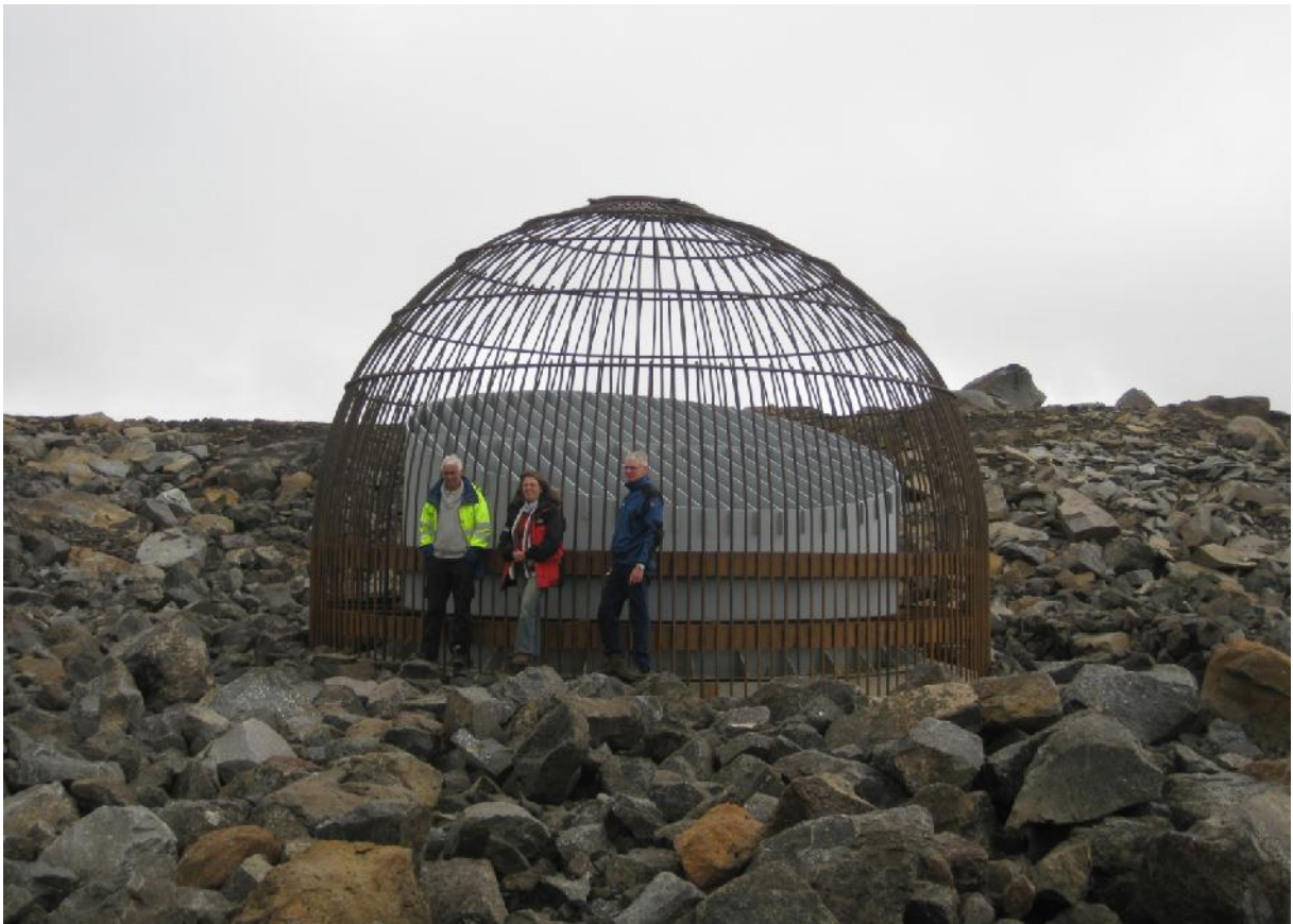
Við Hólsufs voru boruð lóðrétt göng niður að aðrennslisgöngum Kárahnjúkavirkjunar til að leiða vatn uppá yfirborðið til þrýstijöfnunar þegar stöðva þarf vélar Fljótsdalsstöðvar. Stálbúrinu sem komið er fyrir yfir borholunni er ætlað að hindra aðgengi að henni. (16.08.2011)
