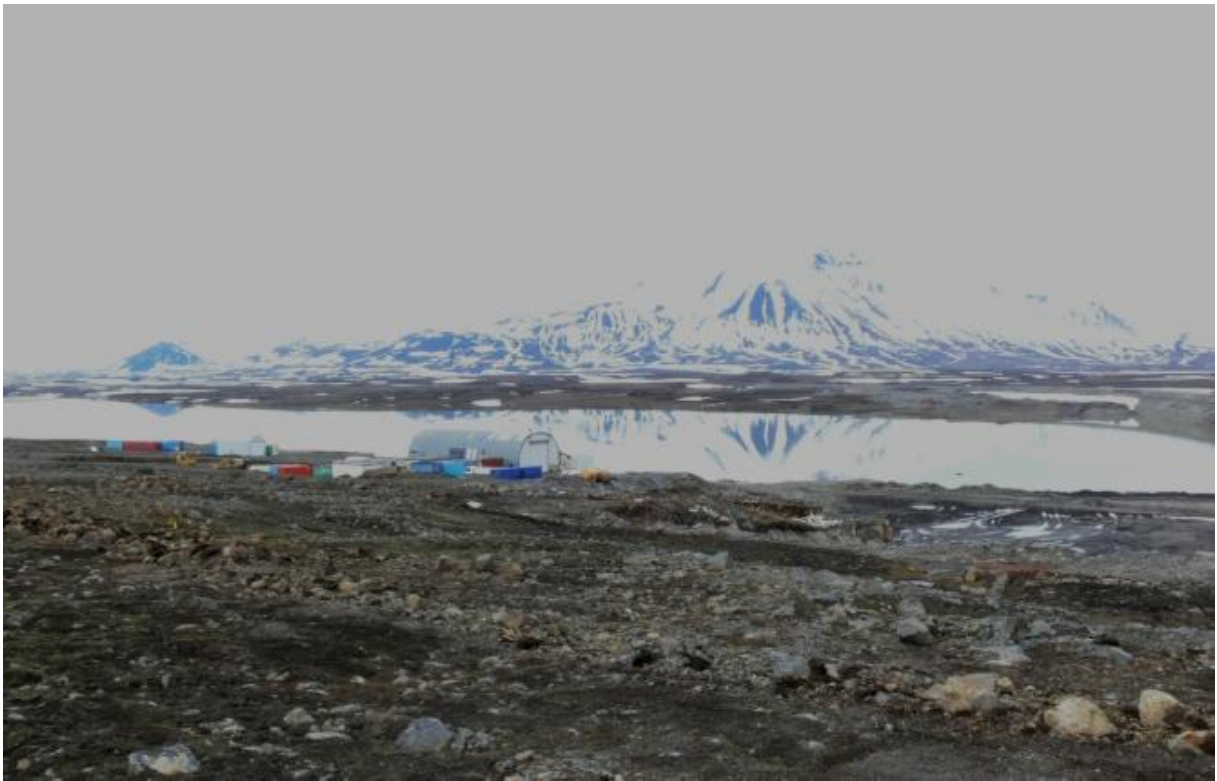
Við aðstöðusköpun á þessum stað var tekin talsverð skering í brekku ofan verkstæðis til að nægjanlegt pláss væri við skemmuna. Steypt plata var undir verkstæðinu. Minni skemma var á öðru plani rétt sunnan við verkstæðið. (20.06.2009)
