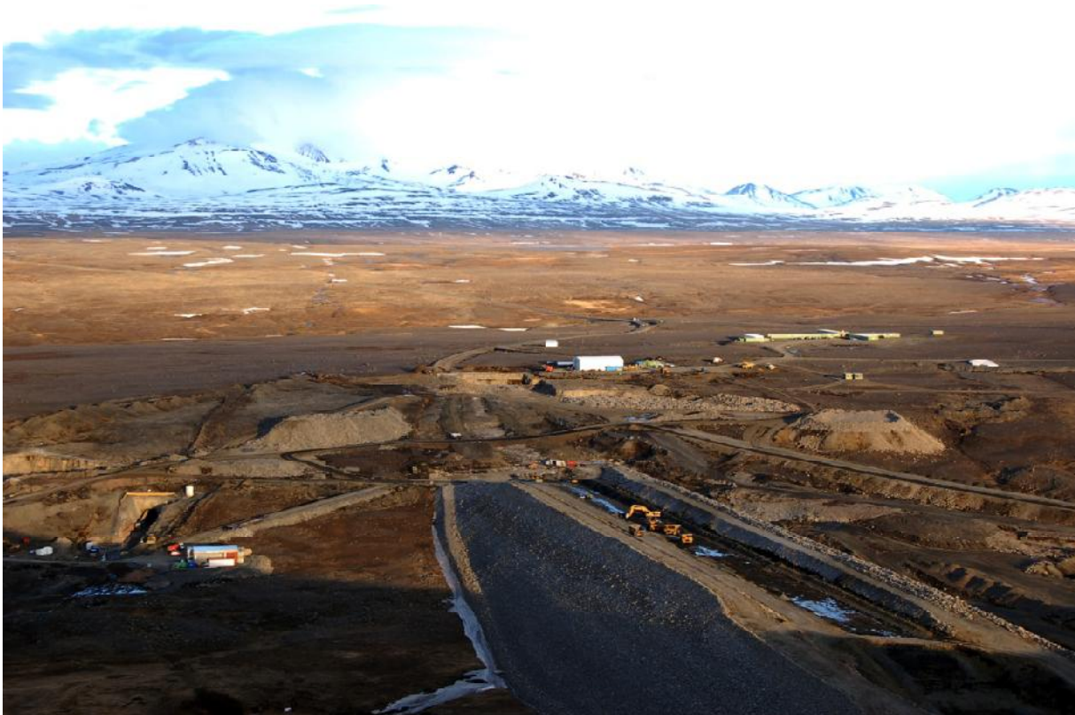
Unnið að byggingu Desjarárstíflu. Aðgöng IV sunnan stíflunnar. Norðan stíflunnar verkstæðisskemma og athafnasvæði, fjær vinnubúðir verktaka. Myndin er tekin af Kárahnjúk. (01.06.2006)
