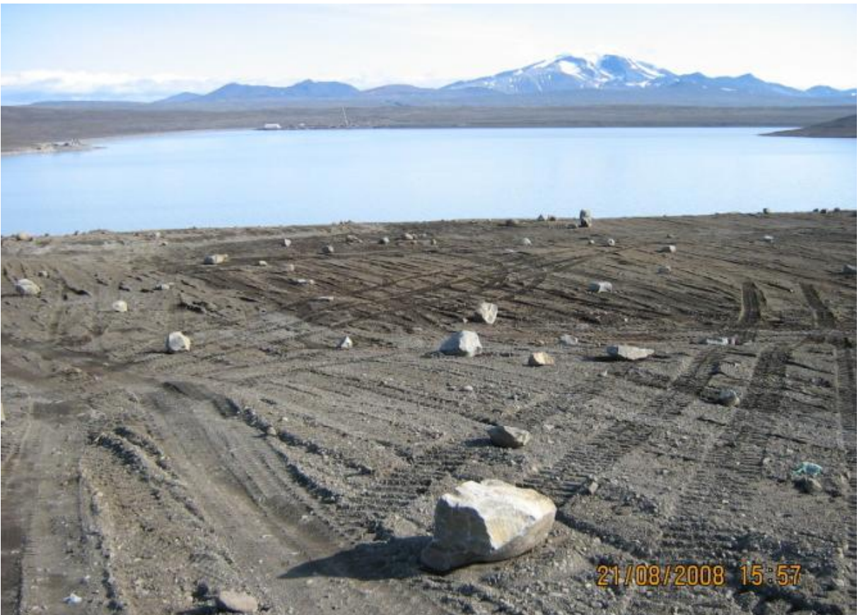
Búið að jafna ofanafýtingu og dreifa grjóti yfir athafnasvæði. (21.08.2008)
