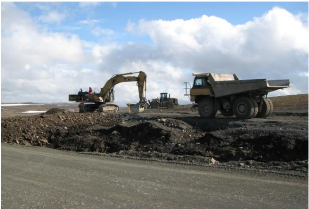
Vegamót aðkomuvegar I og vegar að sveifflugöngum við Miðfell. Talsvert umframefni var flutt frá þessum stað á haugsvæði við Miðfell. (05.06.2008)
