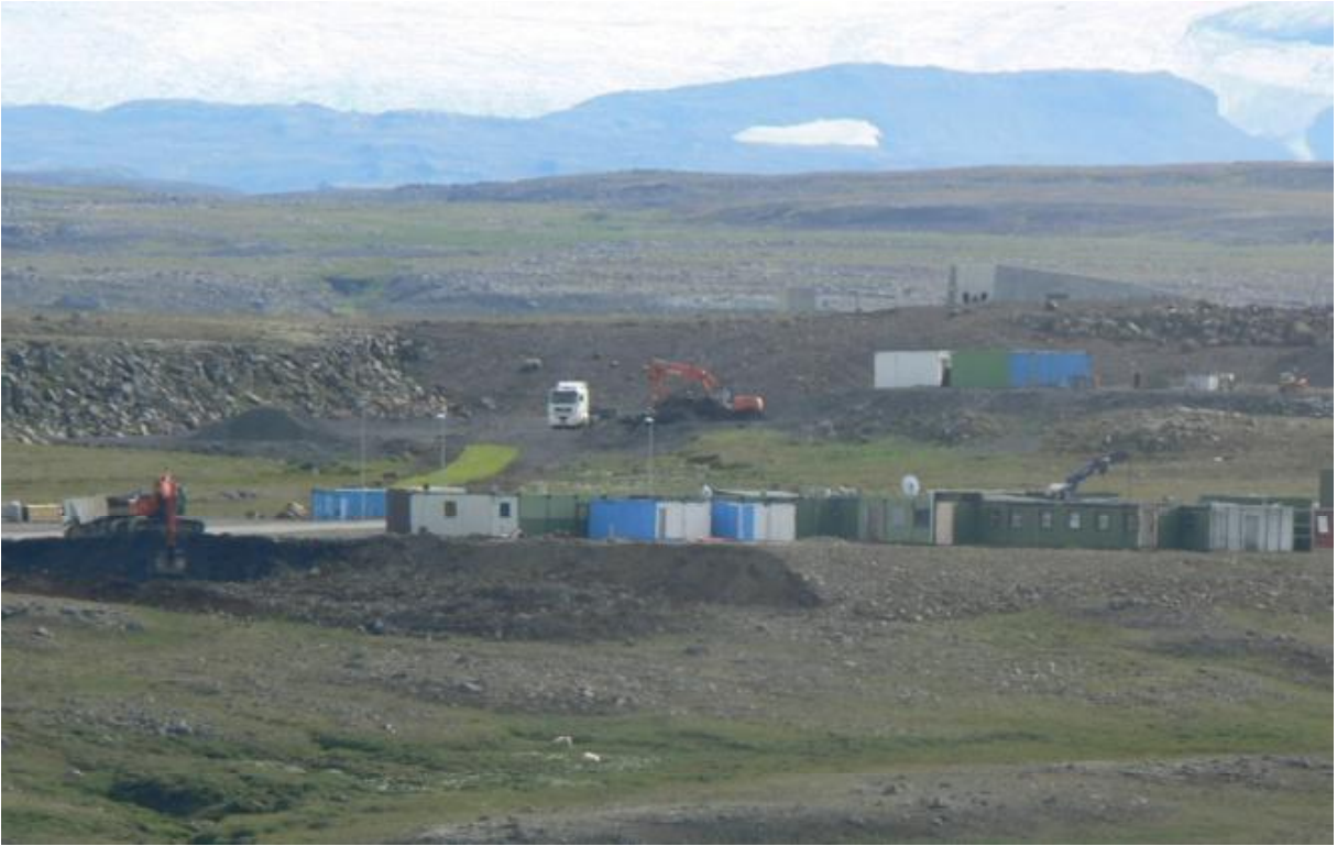
Norðurhluti búðasvæðis. Þarna var gerður þykkur malarpúði undir vinnubúðir. Ekki var talið unnt að koma öllu þessu efni fyrir við búðasvæðið. Þykkasta hluta púðans var því mokað á vörubíla og því komið fyrir á athafnasvæði sem sést í baksýn. (06.08.2010)
