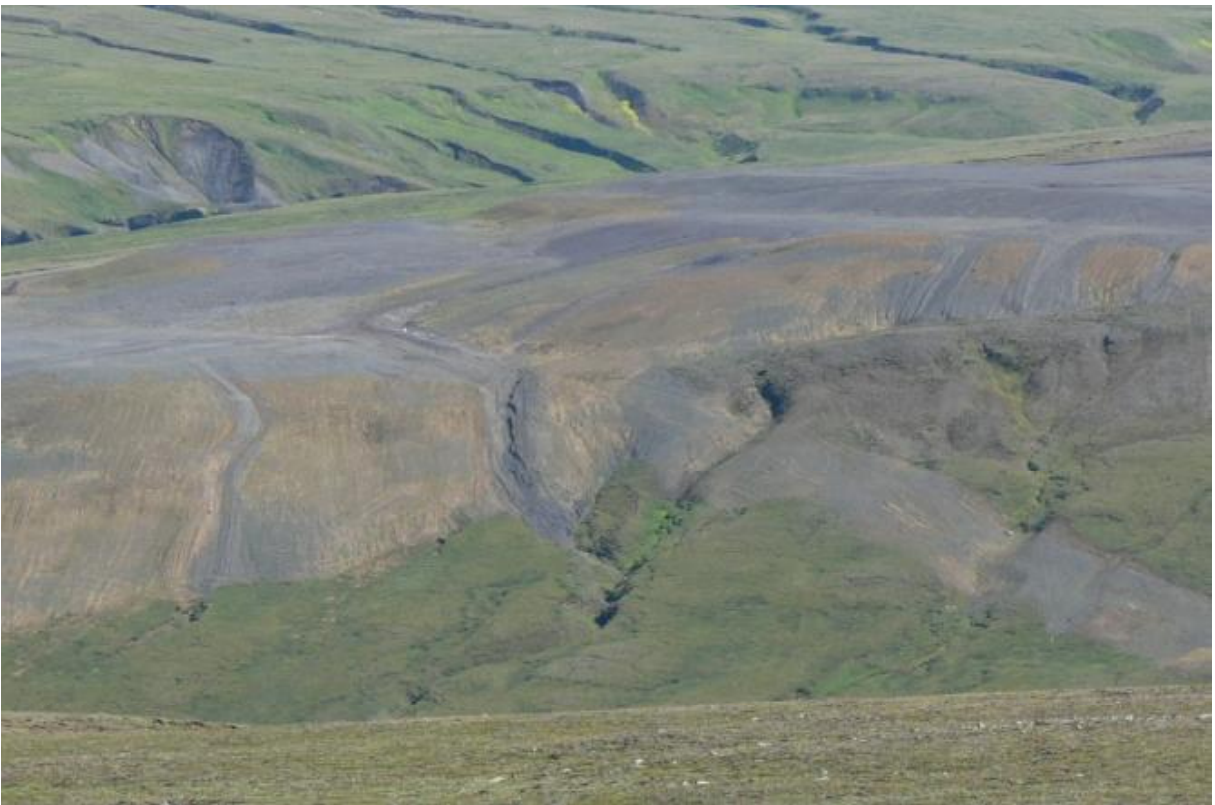
Moldarkenndu efni úr skeringu ofan gangnamunna var ekið á haugsvæðið og því jafnað yfir frambrún þess. Ekki var dreift jarðvegi yfir miðbik haugsvæðis bæði vegna þess að mold var að skornum skammti og á hálsinum næst haugsvæðnu er lítil gróður. (25.07.2010)
