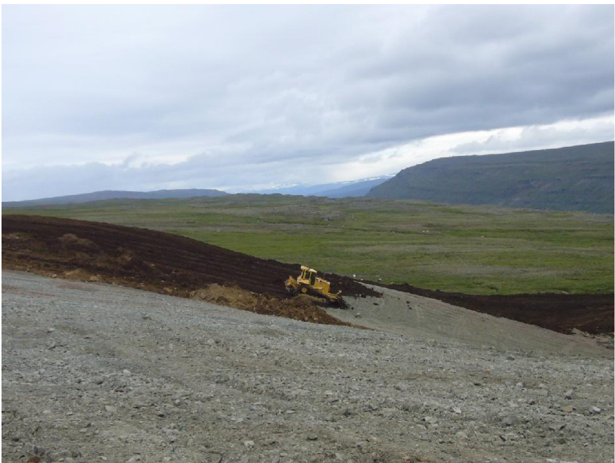
Mold jafnað yfir haugsvæði. (23.07.2009)
