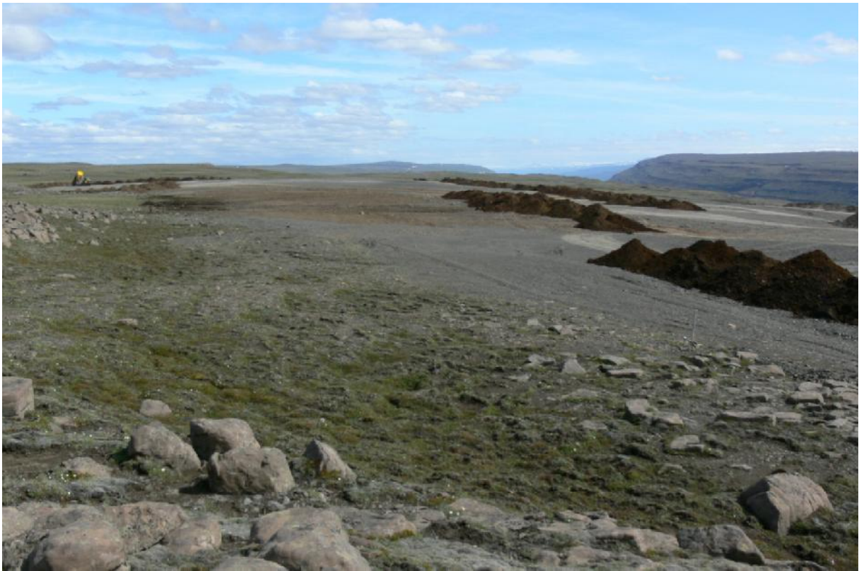
Ofanfýting á efri hluta haugsvæðis. Lögð var áhersla á að fella haugsvæðið að óröskuðu landi þannig að ekki væri um að ræða glögg skil milli haugsvæðis og nánasta umhverfis. (02.07.2009)
