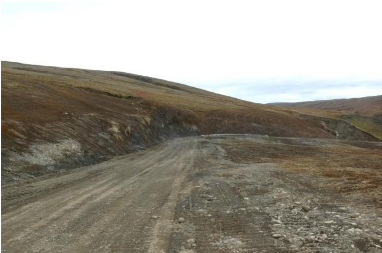
Mótun skeringar lokið. (21.09.2009)
