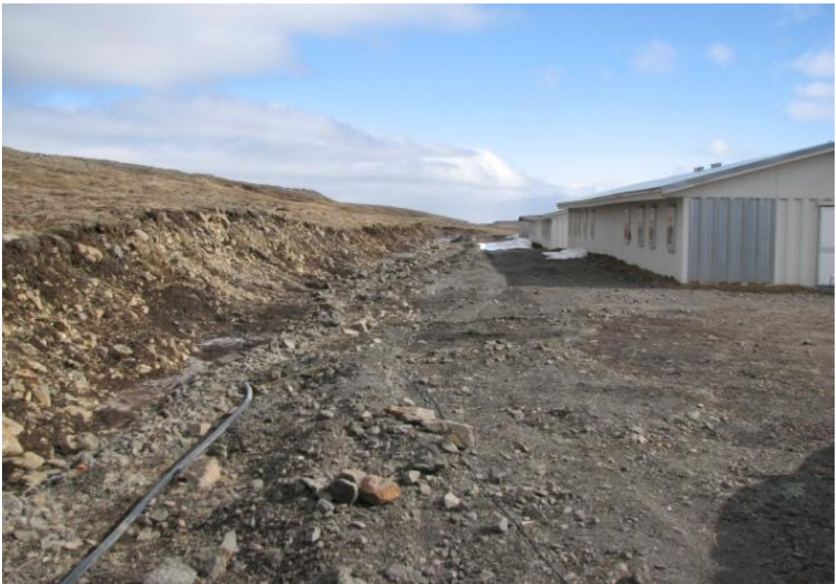
Mörk efri (NV) jaðars búðasvæðis og óhreyfðs lands ofan vinnubúða. Áður en frágangur hófst voru steyptar undirstöður og allar lagnir fjarlægðar. Við frágang þessa svæðis var reynt að móta svæðið að mestu leyti með því efni sem fyrir var í malarpúðum undir vinnubúðum. (10.05.2007)
