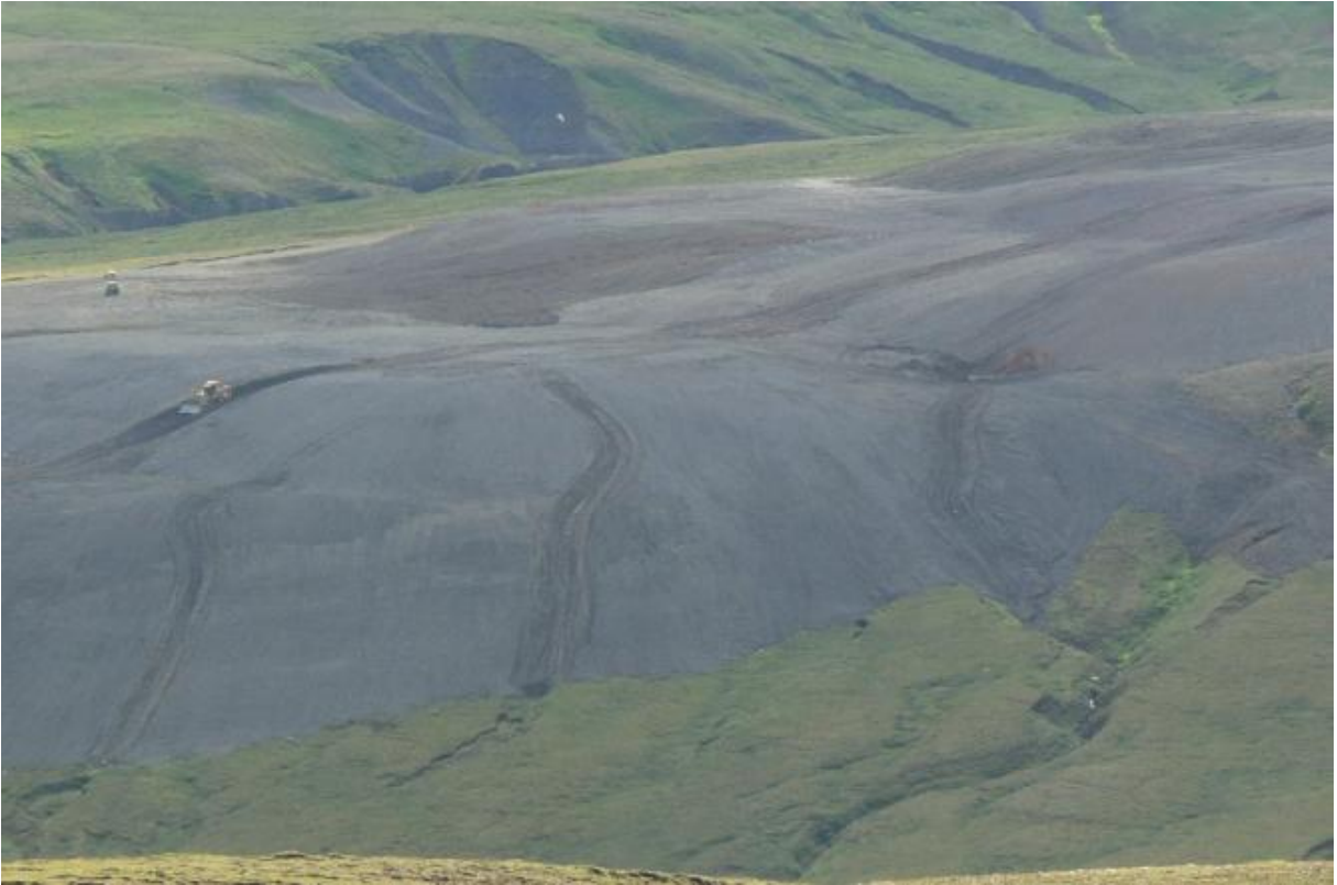
Mótaðar voru rásir í hauginn og þær tengdar gömlum farvegum neðan haugsvæðis. (18.07.2009)
