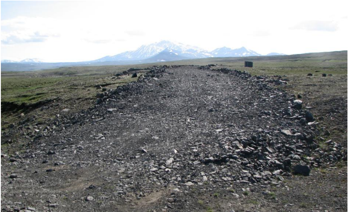
Vegslóð og borplan sunnan aðkomuvegar II ofan vinnubúða. Ekki var talið unnt að koma þessu efni fyrir á staðnum. Þessu efni var mokað á bíl og flutt á haugsvæði. (08.09.2009)
