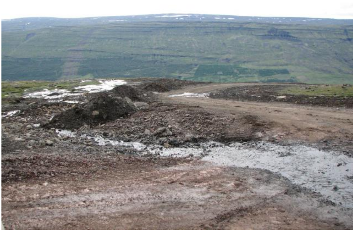
Aðkomuvegur II ofan gangnamunna. Við frágang var lögð áhersla á samspil varanlegra mannvirkja og umhverfis. Reynt var að minnka hættu á vatnsrofi eins og unnt var.
