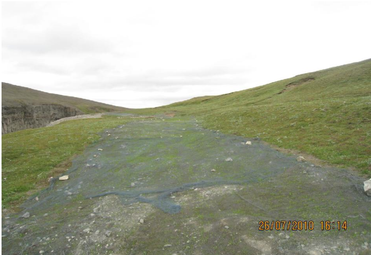
Ystu 200m vegstæðisins voru klæddir loðnunót til að hindra úrrennsli vegna vatnsúða frá fossinum Hverfanda. Nú er vegurinn að gróa upp eins og sést á myndinni. (26.07.2010)
