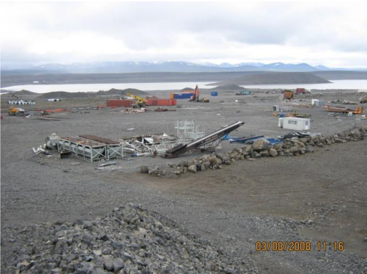
Athafnasvæði verktaka vestan steypustöðvar. (03.08.2008)
