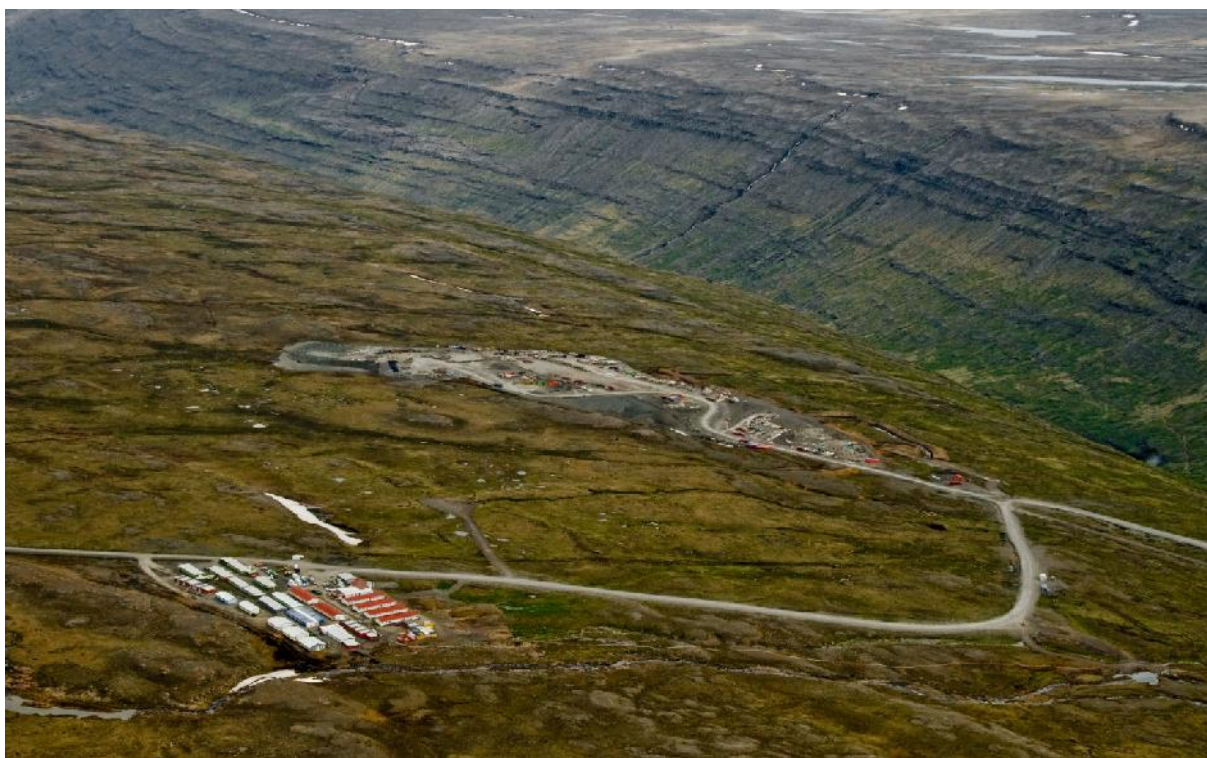
Búðasvæði og haugsvæði. Myndin tekin meðan á framkvæmdum stóð. (25.06.2008)
