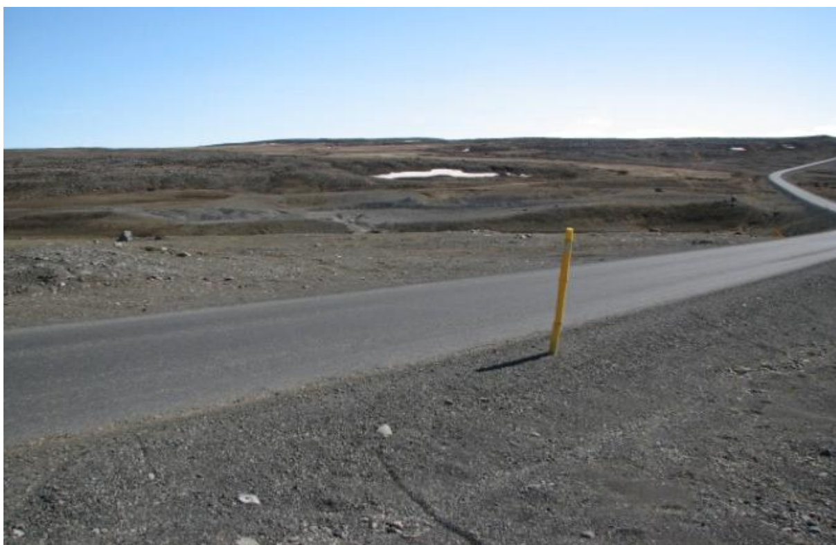
Tekið var efni á þessum stað við lagningu Kárhjúkavegar. Við frágang námunnar var lögð áhersla á að leiða vatn um námusvæðið út í farveg Glúmsstaðadalsár til að draga úr vatnsrofi við námuna. Jaðrar námunnar voru mótaðir í líkingu við óhreyfða bakka utan námunnar. (06.06.2007)
