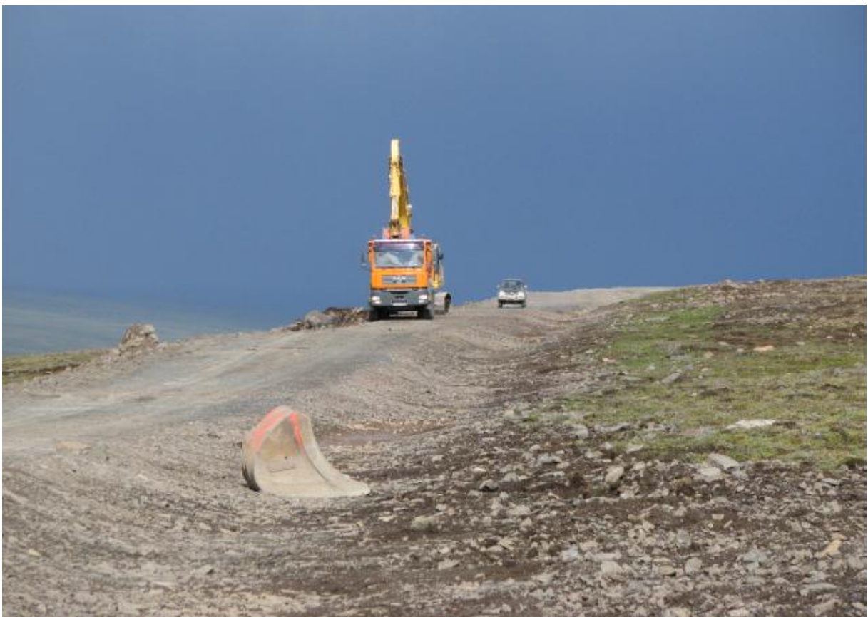
Vegur að sveiflugöngum. Umframefni, sem ekki var unnt að koma fyrir á ásættanlegan hátt við veginn, var mokað á vörubíl og fjarlæggt. (13.08.2009)
