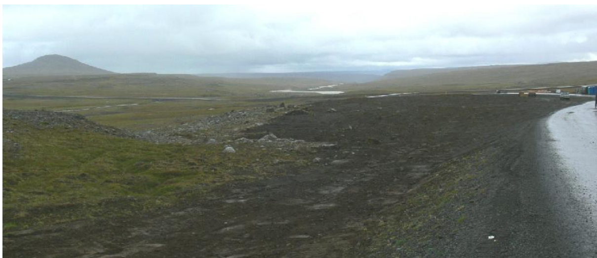
Frágengið búðasvæði. Umframefni var flutt á athafnasvæði verktaka austan aðkomuvegar. Svæðið verður grætt upp. (10.09.2010)
