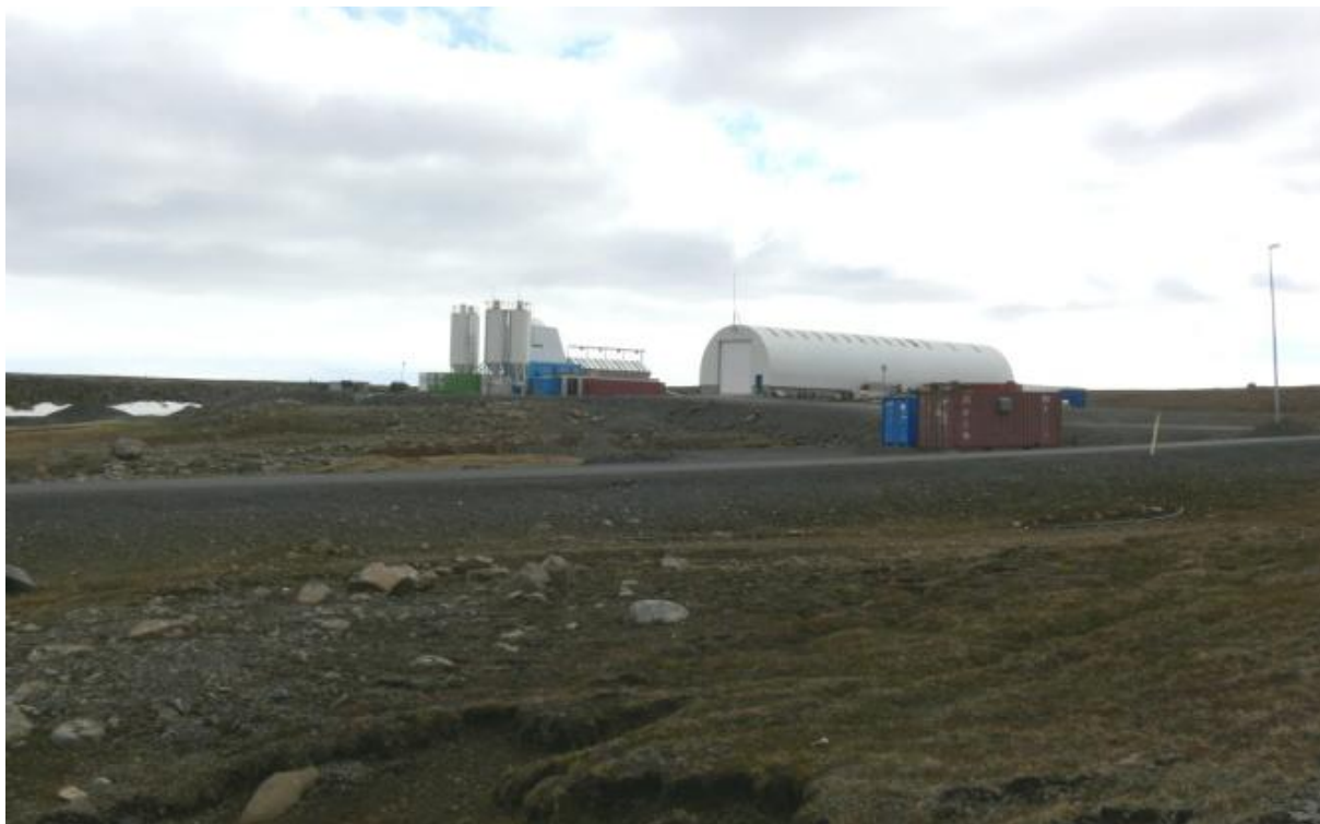
Steyrustöð og verkstæðisskemma á steiptum undirstöðum. (07.06.2010)
