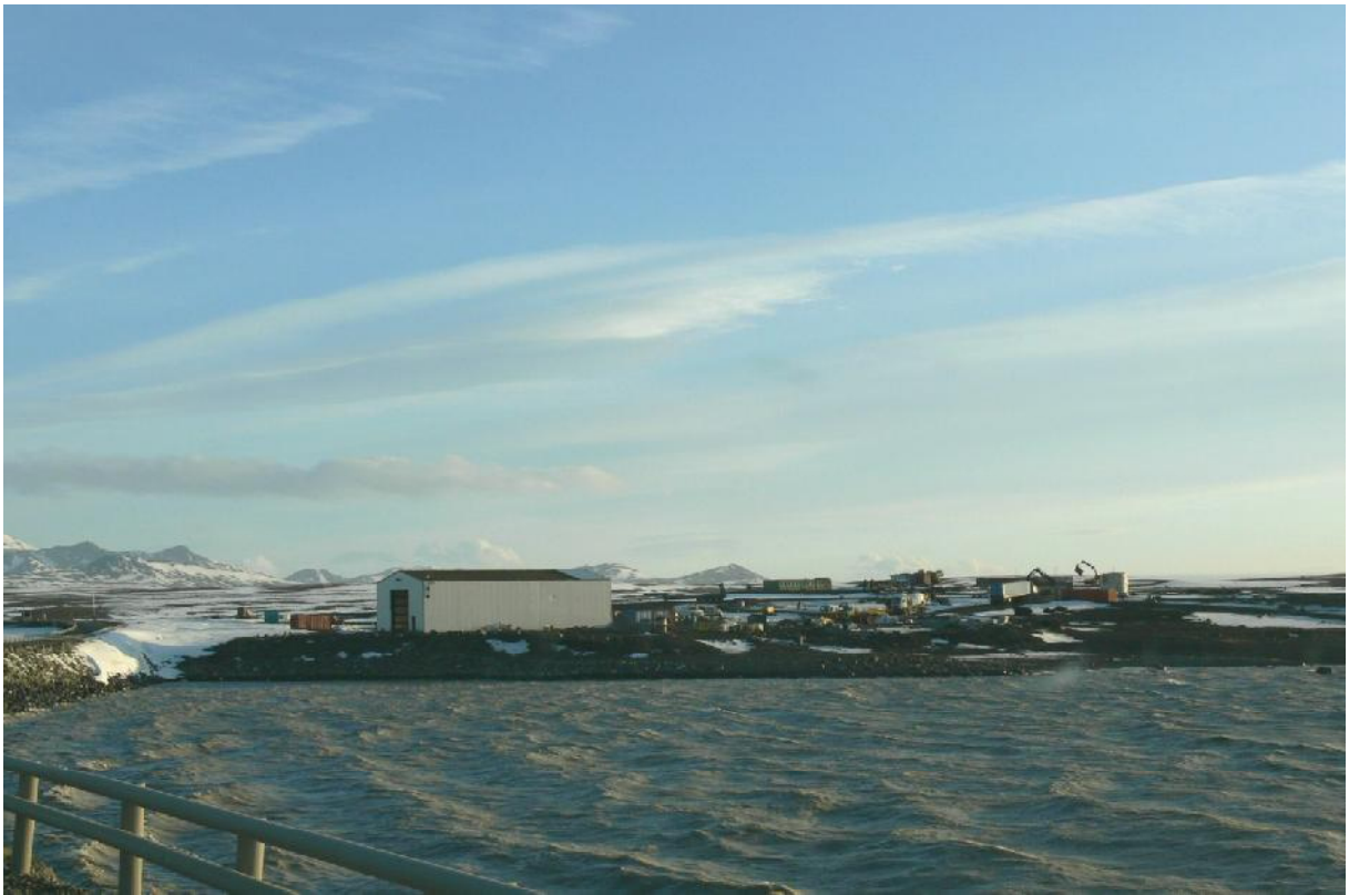
Við verklok voru öll mannvirki fjarlægð. Steyptar undirstöður voru fjarlægðar og steypuúrgangur urðaður. Allar lagnir og rafmagnsleiðslur voru fjarlægðar. (15.10.2009)
