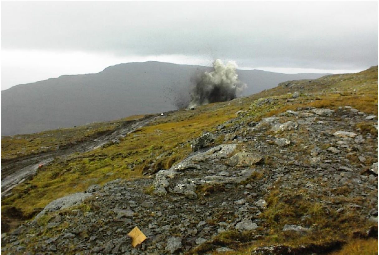
Upphaf framkvæmda við Aðkomugöng. Horft til suðurs.
