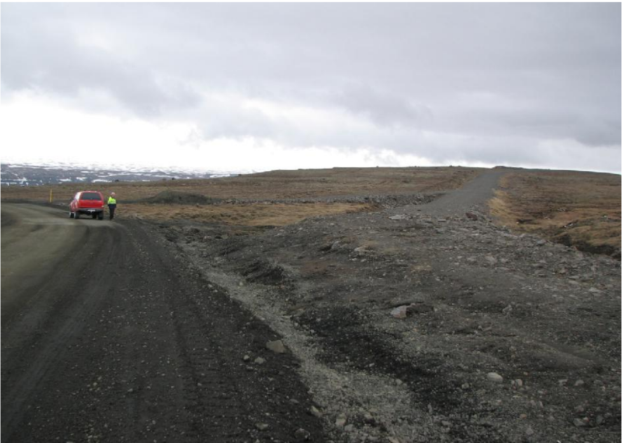
Vegamót að komuvegar I og Ljósármunnavegar, en sá vegur var lagður vegna fyrirhugaðra framkvæmda við Fljótsdalsvirkjun. Þarna var önnur vegtenging fjarlægð og fláar mótaðir. (09.05.2007)
