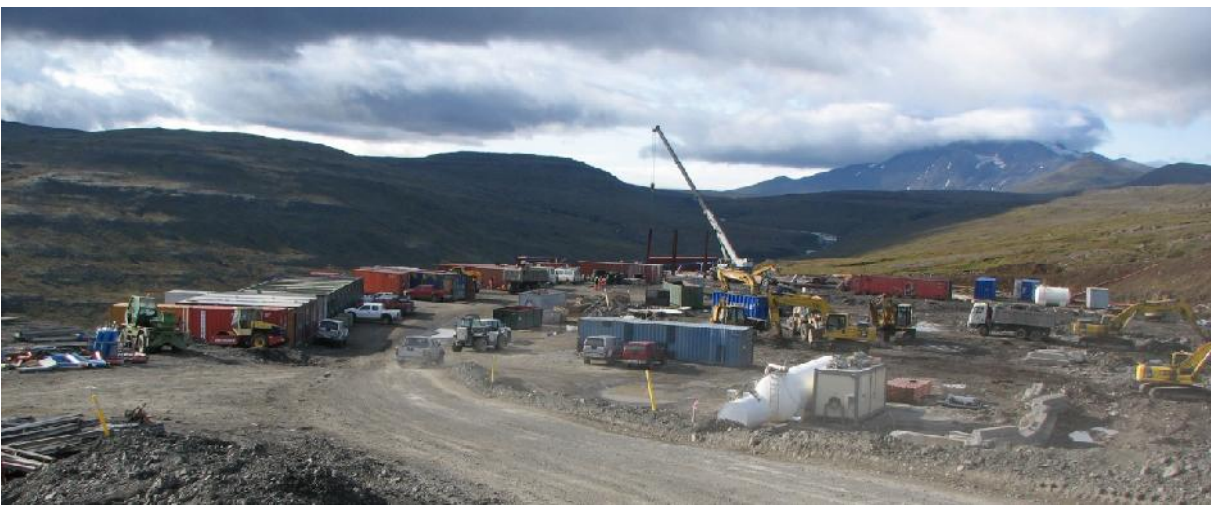
Starfsmenn Impregilo fjarlægja tæki og búnað á athafnasvæði við aðgöng II. Brún plans neðan við rauða gáma til vinstri á myndinni var dregin inn á planið til að mynda aflíðandi brekku neðan vegar í líkingu við óraskað land utan athafnasvæðis.
