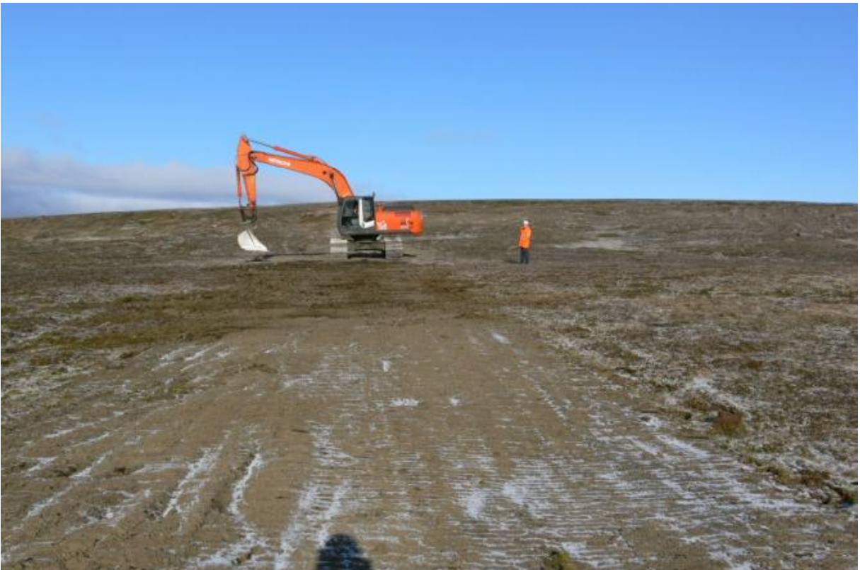
Ofaníburður var fjarlægður og vegsvæði jafnað. Landnámi grenndargróðurs verður flýtt með áburðargjöf. (29.08.2009)
