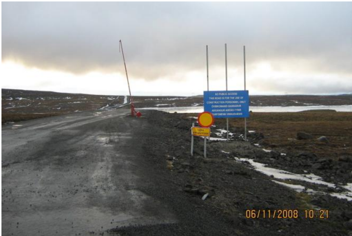
Vegamót aðkomuvegar I og Kárahnjúkavegar. Vegurinn var mjókkaður þar sem hann var breiðari en 7 m. Umframefni var komið fyrir í vegfláum. (06.11.2008)
