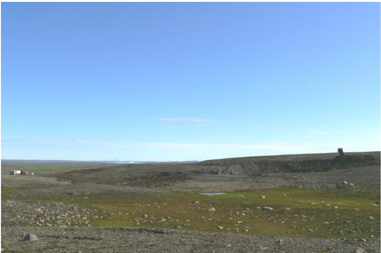
Efni úr vegum og plönnum sem ekki var hægt að koma fyrir á ásættanlegan hátt var flutt í námu, m.a. til að hylja steypuúrgang. (19.07.2010)
