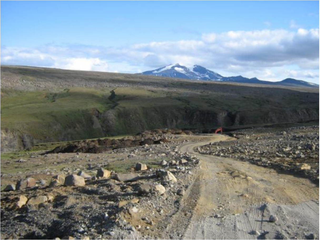
Búið að fjarlægja útbúnað og frágangur hafinn við plan. Grafín var gryfja við planið til að koma þar fyrir aðfluttu efni og fá meira af moldarkenndum jarðvegi til frágangs. (13.07.2008)
