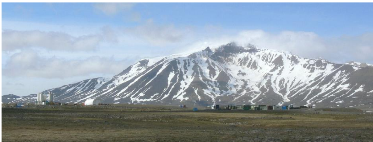
Yfirlitsmynd . Vinnubúðir og athafnasvæði verktaka við Ufsarstíflu. (13.06.2010)
