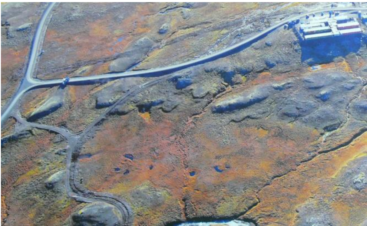
Vegir að vinnubúðum við Ufsarstiflu. Fremst á myndinni er eldri vegur sem var fjarlægður. Efni úr veginum var mokað upp og því ýmist ekið burt eða notað til frágangs á skeringum og námum. (10.08.2010)
