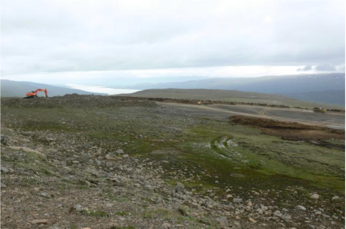
Jarðvegi ekið að efri brún haugsvæðis. (22.07.2009)
