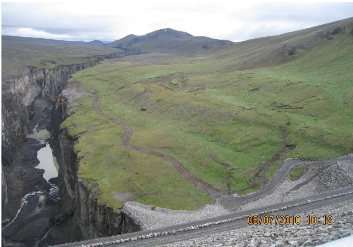
Framkvæmdum lauk sumarið 2009 og var vegurinn fjarlægður í september það ár. Þegar dúkurinn var fjarlægður var gróðurhulan undir honum nær horfin og var vegstæðið nú sár í grónum bakkanum eins og sést á myndinni. (06.07.2010)
