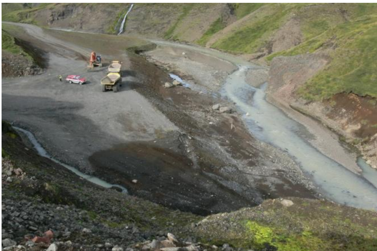
Búið er að fjarlægja steypa plötu og hluta plans í og við farveg Glúmsstaðadalsár. (18.08.2009)
