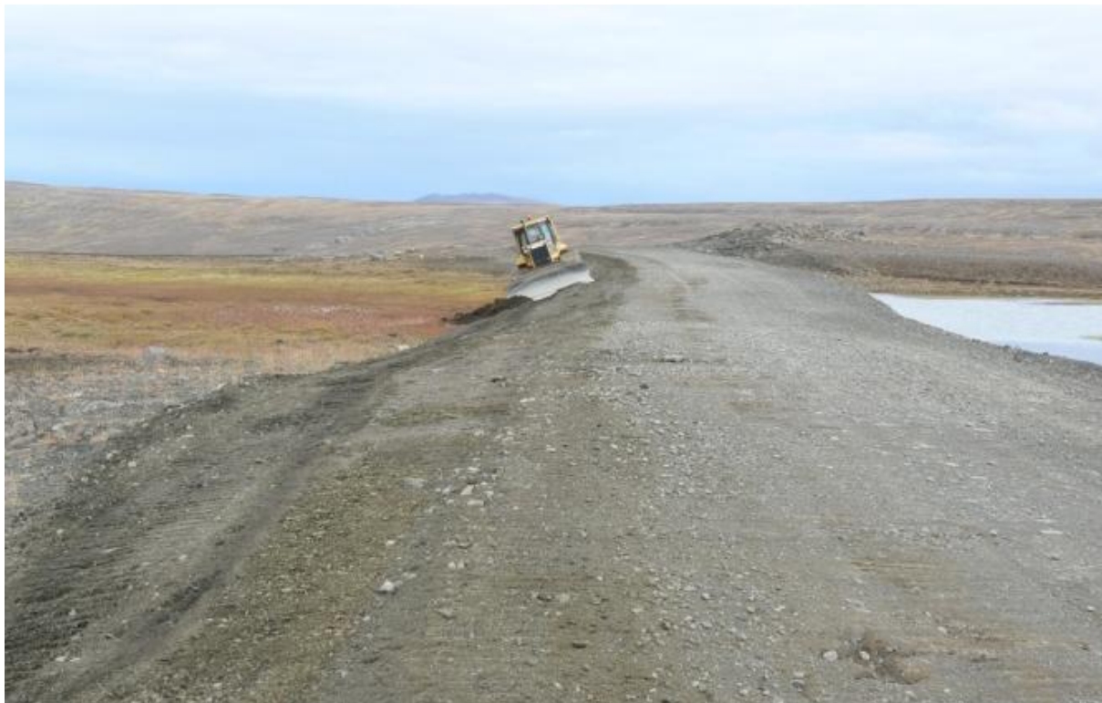
Vegfláar voru mótaðir með halla 1:2-1:4 eftir aðstæðum. Þetta var gert til að fella veginn betur að landi og draga úr líkum á úrrennsli úr veginum. (21.09.2009)
