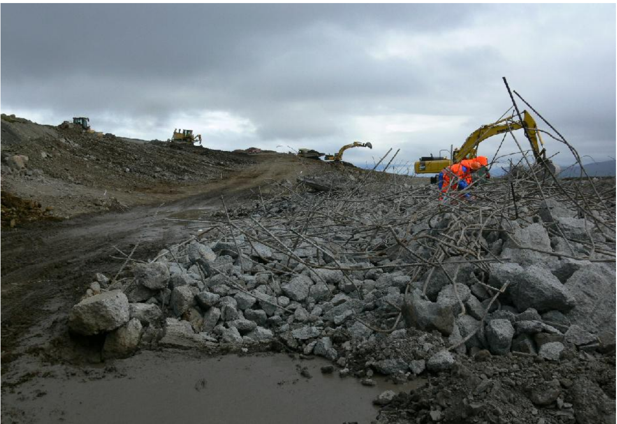
Jarðgangaborinn var settur saman utan við gangnamunnan. Steypa þurfti plötu undir borinn meðan á samsetningu stóð. Steypa var urðuð á haugsvæði, en járn flutt til endurvinnslu. Verið er að grófmóta brekku og færa veg ofar um athafnasvæðið. Horft til norðurs.
