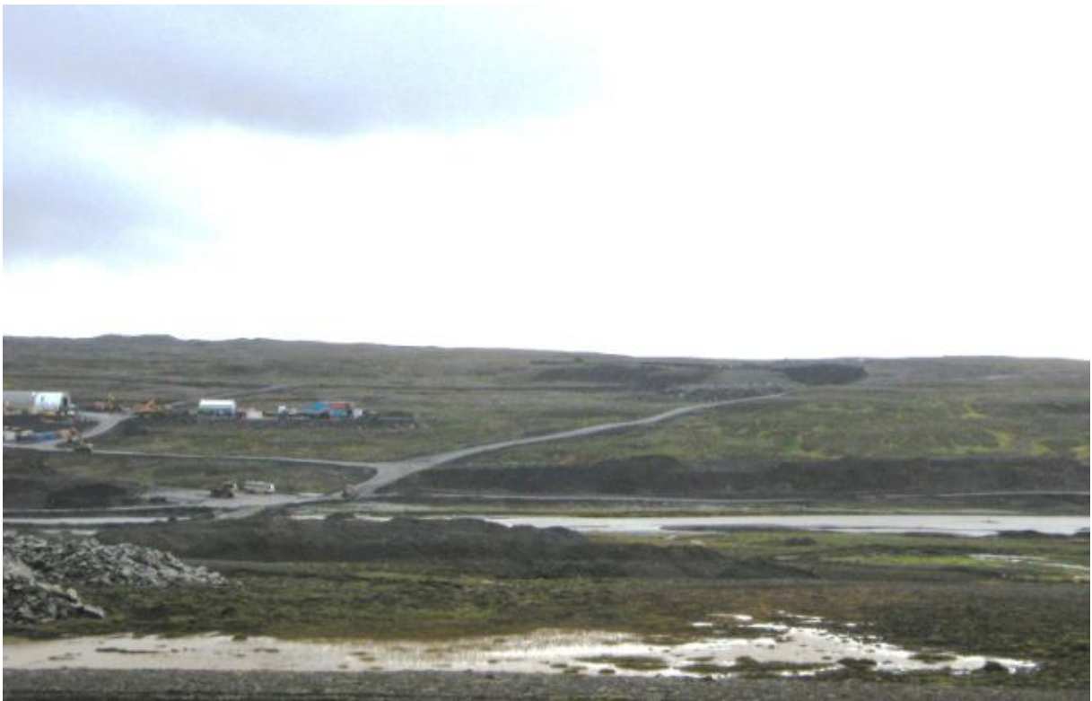
Aðstaða verktaka og náma austan Kelduárstíflu. Vegir og plön ofan lónborðs voru fjarlægð. Efninu var að hluta komið fyrir í námunni. (14.08.2008)
