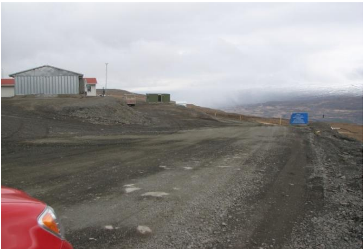
Neðri (Suður) hluti vinnubúða. Aðkomuvegur I var færður ofar á búðasvæðið, á stallinn fyrir miðri mynd. Með því að færa veginn var unnt að koma meira umfræfni fyrir neðan vegar auk þess sem auðveldara var að fella búðasvæðið betur að óröskuðu landi utan þess. (09.05.2007)
