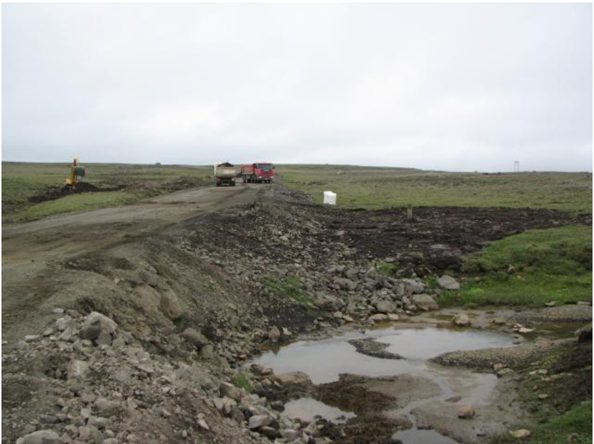
Efni úr þremur borplönnum var notað til að loka skurði og koma í veg fyrir úrrennsli. (15.07.2009)
