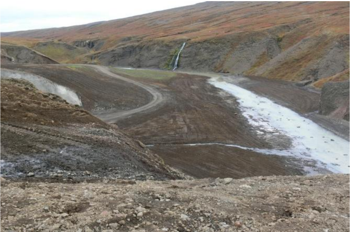
Landmótun lokið. Gerður var farvegur fyrir úrrennsli úr göngum um mitt svæðið. (21.09.2009)
