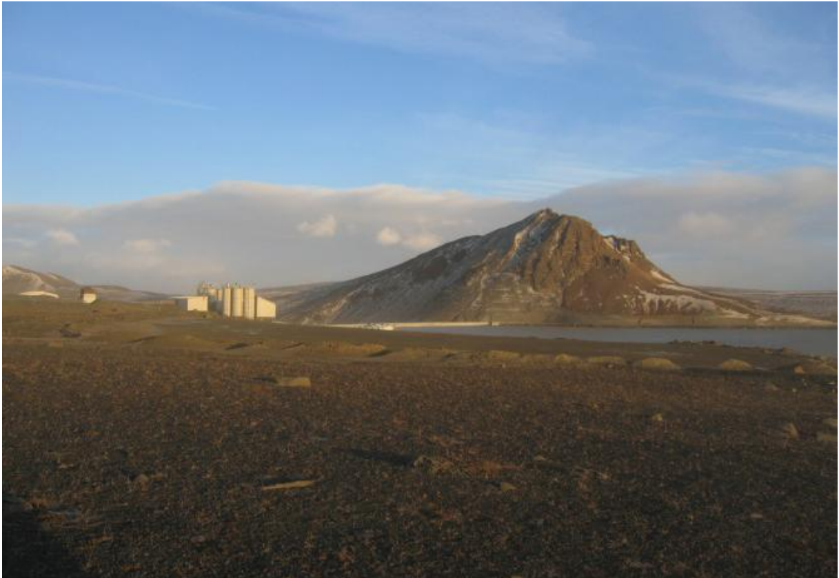
Steypustöð var skammt sunnan Kárahnjúkastiflu milli aðkomuvegar og lóns. (05.11.2007)
