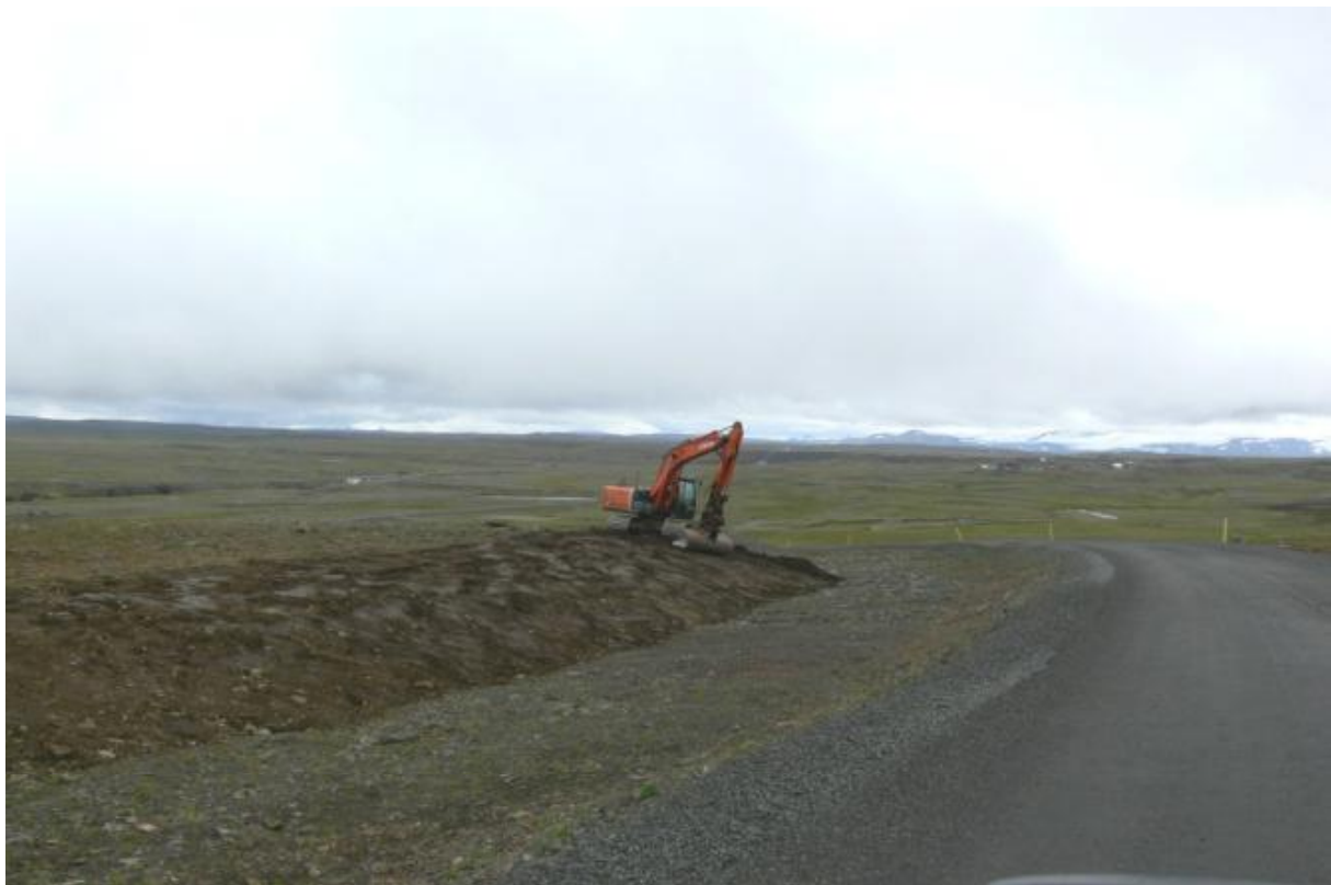
Skering sunnan sveifluganga. Efri brún skeringar var „rúnnuð“ og flótt út til samræmis við landform í næsta nágrenni. (17.08.2010)
