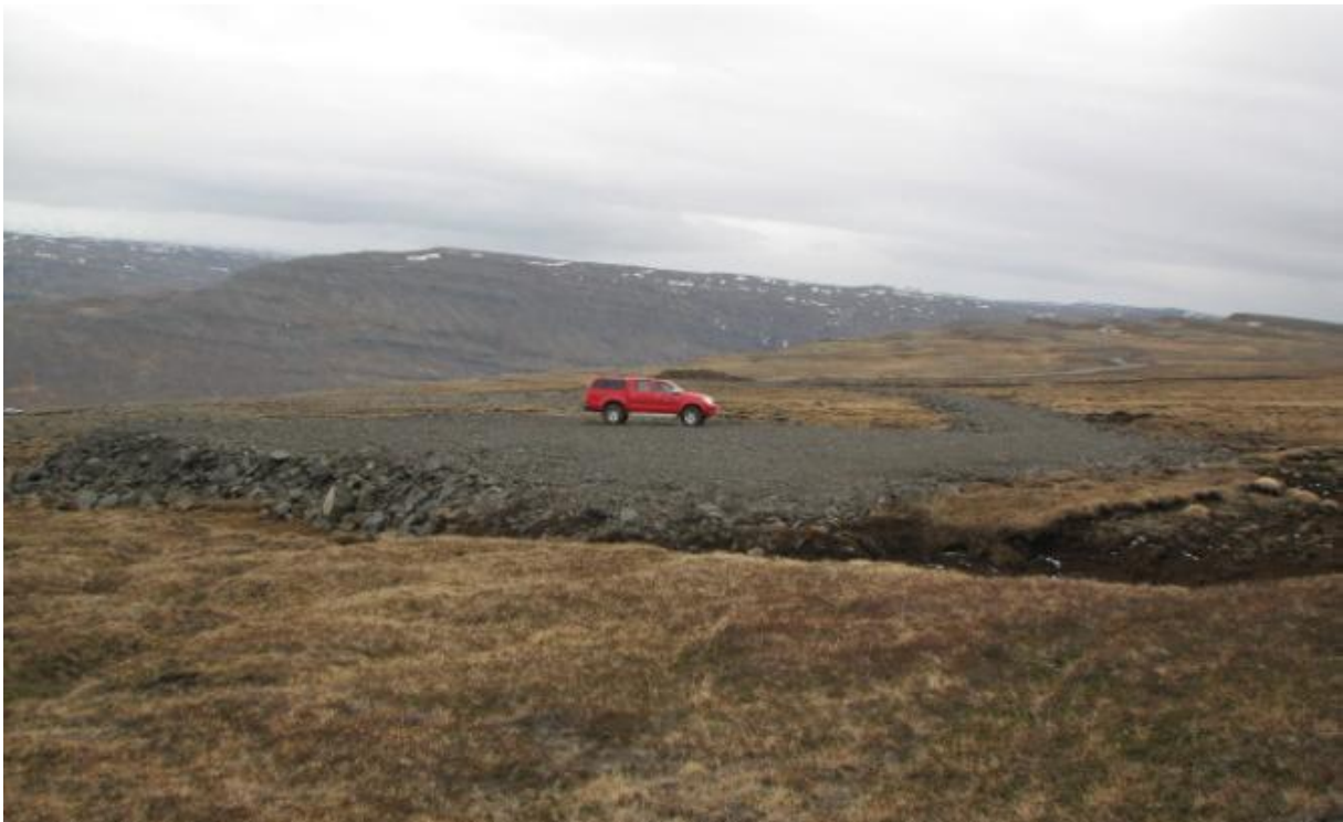
Við upphaf framkvæmda var borað eftir vatni á ýmsum stöðum við aðkomuveg I. Planið á myndinni var norðan við vinnubúðir. Að planinu lá um 300 m langur vegur frá aðkomuvegi I. Ekki var unnt að koma efni úr plani og vegi fyrir í landinu. (09.05.2007)
