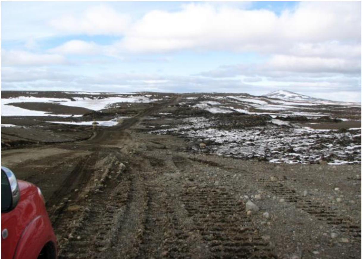
Vegurinn og vegsvæðið lét talsvert á sjá eftir mikla umferð steypubíla að loftunarholu. (10.05.2007)
