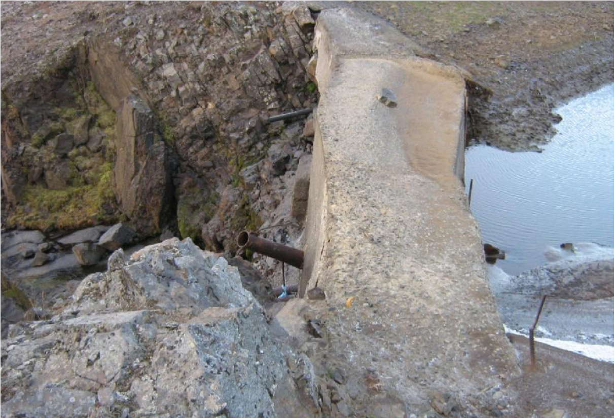
Steypt stífla í Axará neðan vinnubúða. Stíflan var gerð vegna vatnstöku úr ánni. (30.09.2008)
